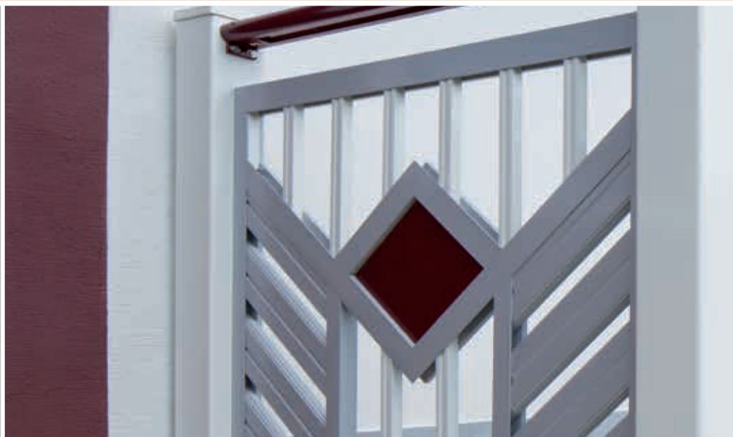
279 Altenmarkt Balkongeländer, 3-färbig
