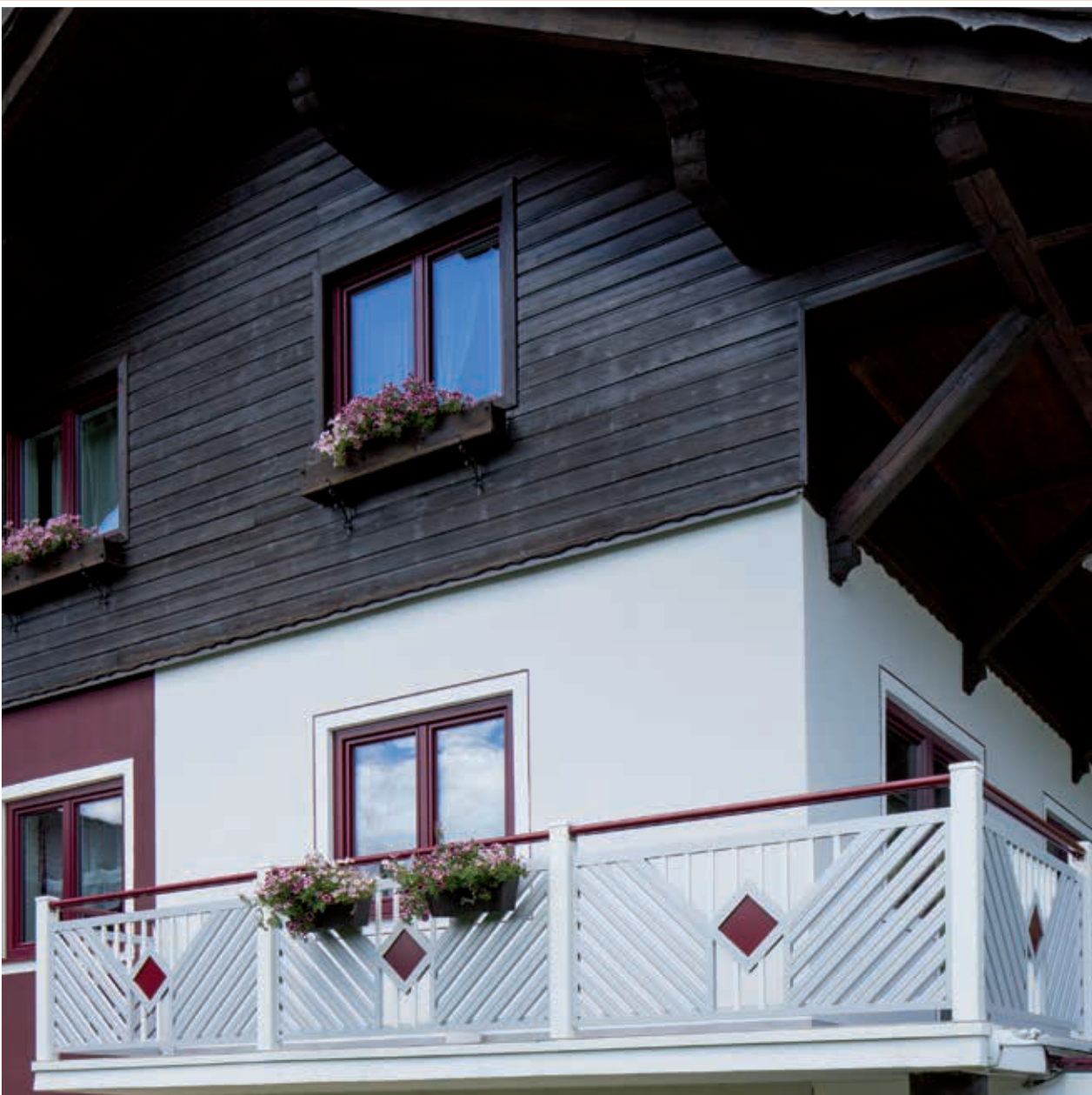
282 Altenmarkt Balkongeländer, 3-färbig
